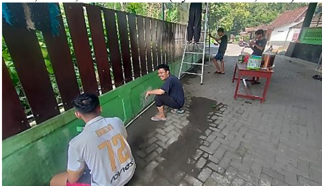
Gambar 22. Kerja bakti pengecatan masjid
