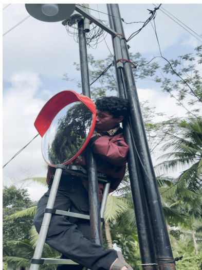
Gambar 7. Proses Pemasangan Convex Mirror
