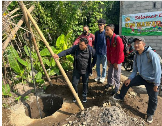
Gambar 9. Kegiatan Pembangunan Sumur Air Bersih
